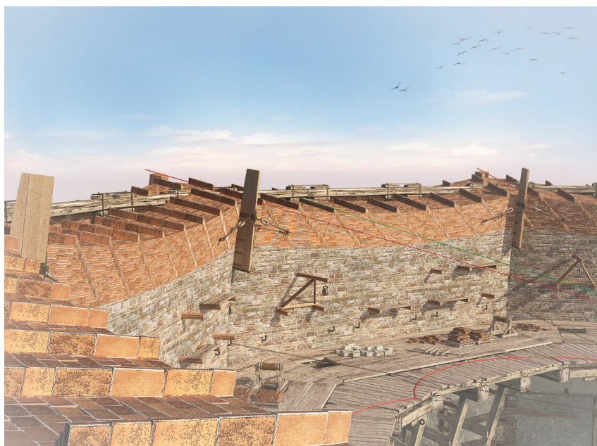
Ricostruzione della murata della cupola; in evidenza i mattoni a "spina pesce" (Ricci, Sichi, Di Mauro)
